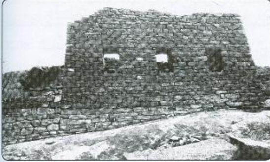
صورة ١: جدار الواجهة الجنوبية للمبنى - شُعب العُقل
