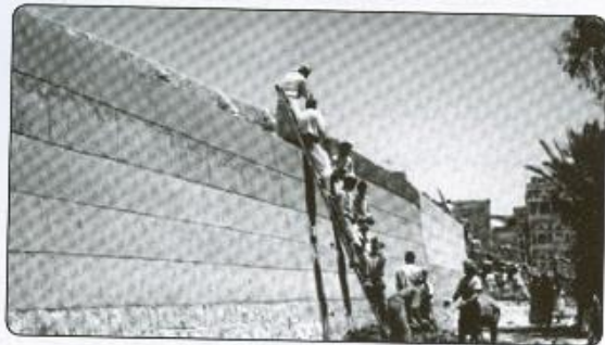
صور (١١ و١٢): توضح ترميم سور مدينة صنعاء القديمة
