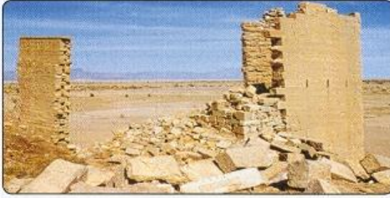
صورة ٤: جدران سور مدينة معين (قرناو) الذي بني بطريقة الجدران المزدوجة المجوفة (Hollow wall)
