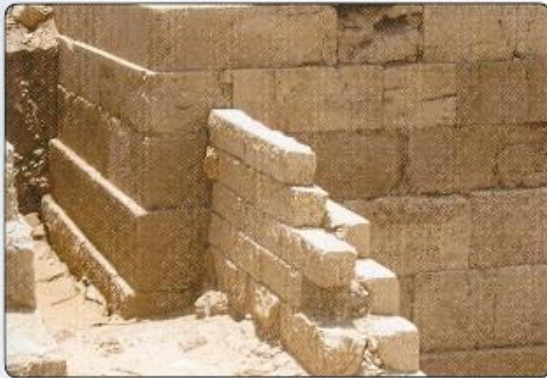
صورة ٢: ارتداد المداميك العليا عن التي أسفلها للداخل
