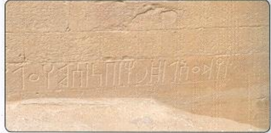
صورة ٣: صورة توضح طريقة صقل جوانب الحجر من أعلى وأسفل والجانبين صقلاً ناعماً جداً بحيث يبدو الجدار كتلة واحدة (صروح)
